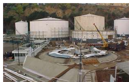
Imágenes del dismantelamiento de los estanques de las petroleras del sector Las Salinas
