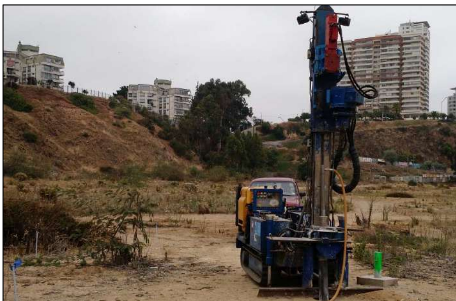
Figura 3: Inyección de reactivo en los puntos de inyección
