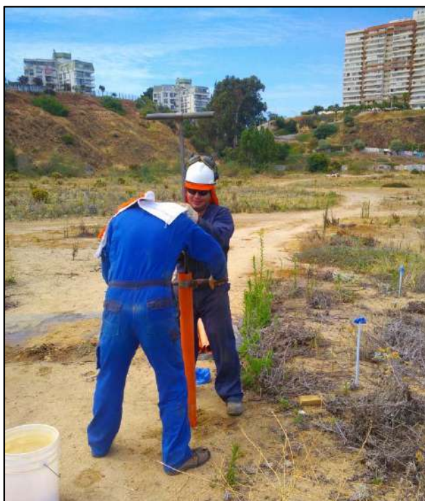
Figura 1: Actividades de perforación pozos de monitoreo de la prueba
