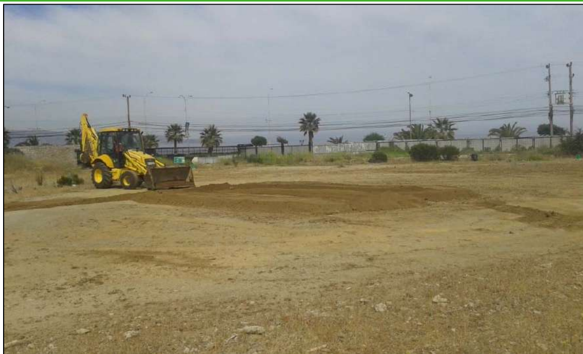
Imagen 3. Acondicionamiento de la base del terreno en el área de montaje de la biopila.
