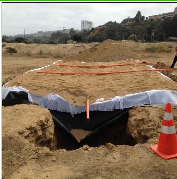
Imagen 4. Montaje de la base de geomembrana-geotextil, tuberías de aireación, tubería de recolección de lixiviado y base de suelo limpio.
