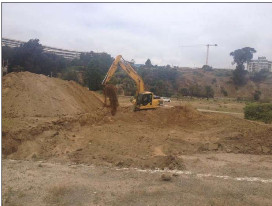
Imagen 1. Inicio de la excavación para la extracción de suelo para el montaje de la biopila.
