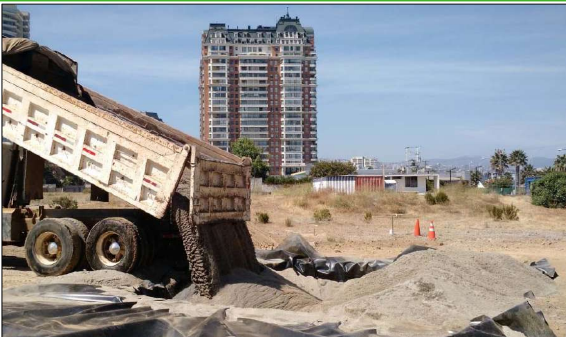
Imagen 5. Proceso de descarga de suelo impactado a plataforma de biopila.
