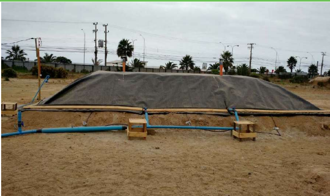
Imagen 6. Montaje final de la biopila, con tuberías de aireación, válvulas de regulación de flujo de aire y puntos de muestreo.
