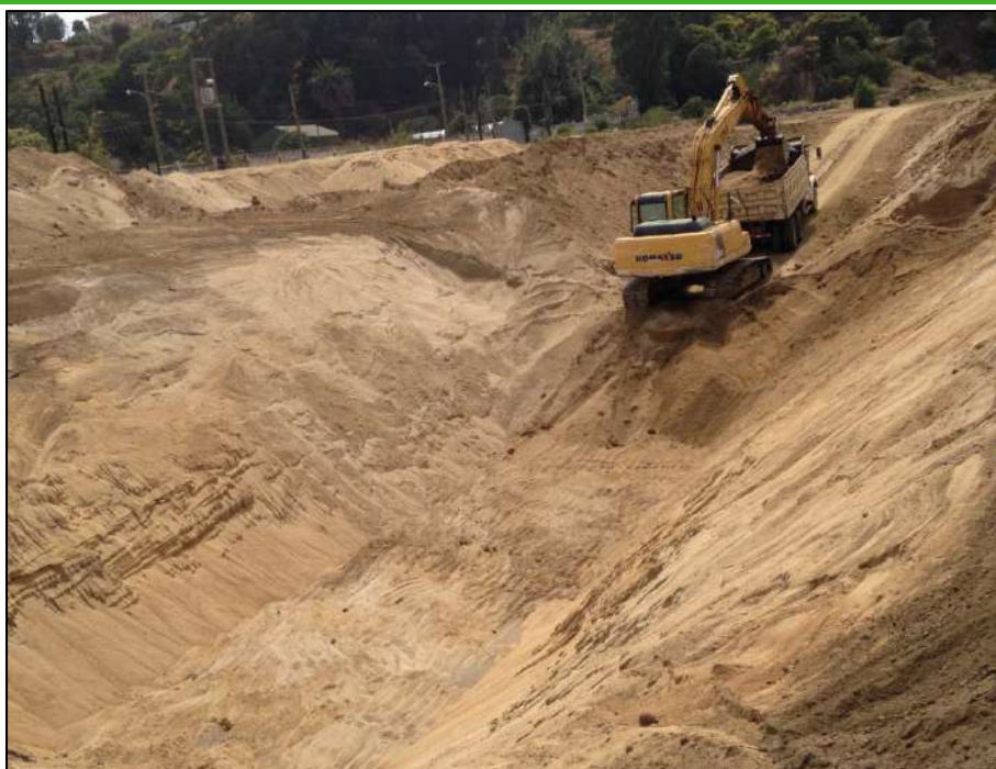
Imagen 2. Término de excavación y carguío de camiones para el traslado del suelo al sitio de montaje de la biopila.
