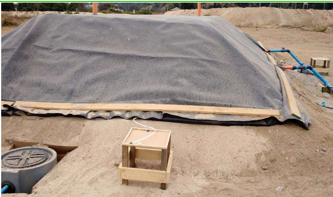
Imagen 8. Tubo para el monitoreo de gases al interior de la biopila.
