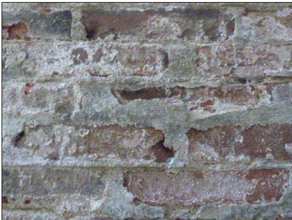
Fotografía 3-47. Detalle constructivo del túnel, mortero compuesto por cal quemada.
