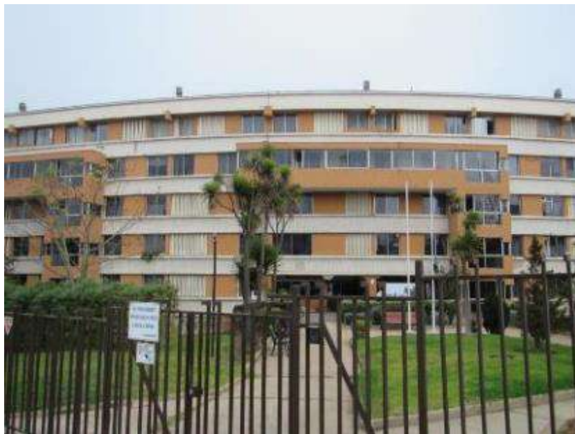
Fotografía 3-64. Edificios Subida Alessandri
