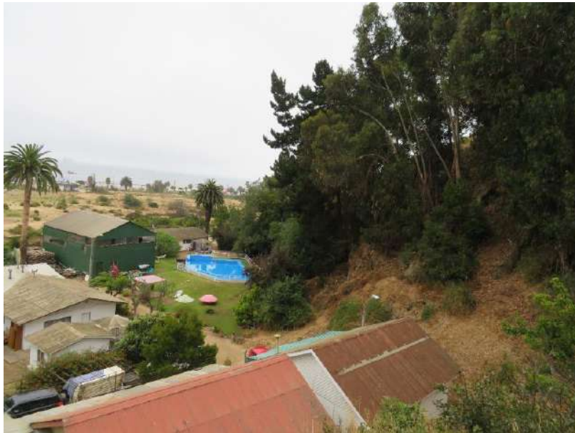
Fotografía 3-18. Vista general de las construcciones del sitio de Bienes Nacionales
