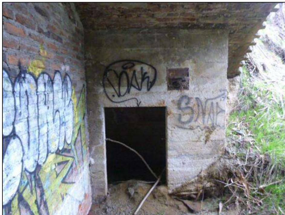
Fotografía 3-1. Interior del túnel, construcción subactual en sector SO.
