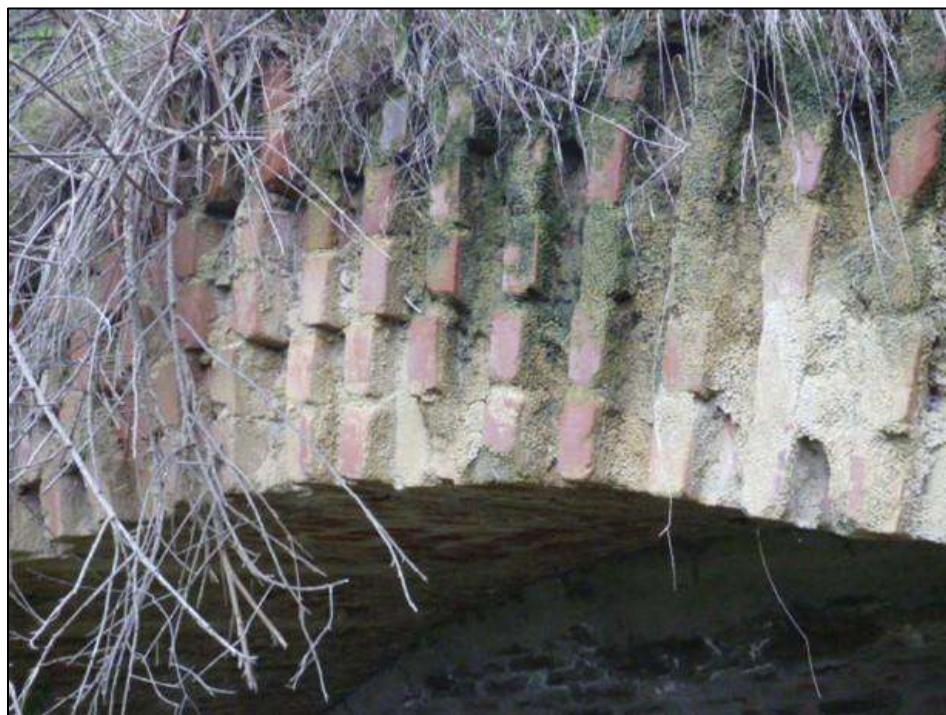
Fotografía 3-46. Detalle constructivo del túnel.
