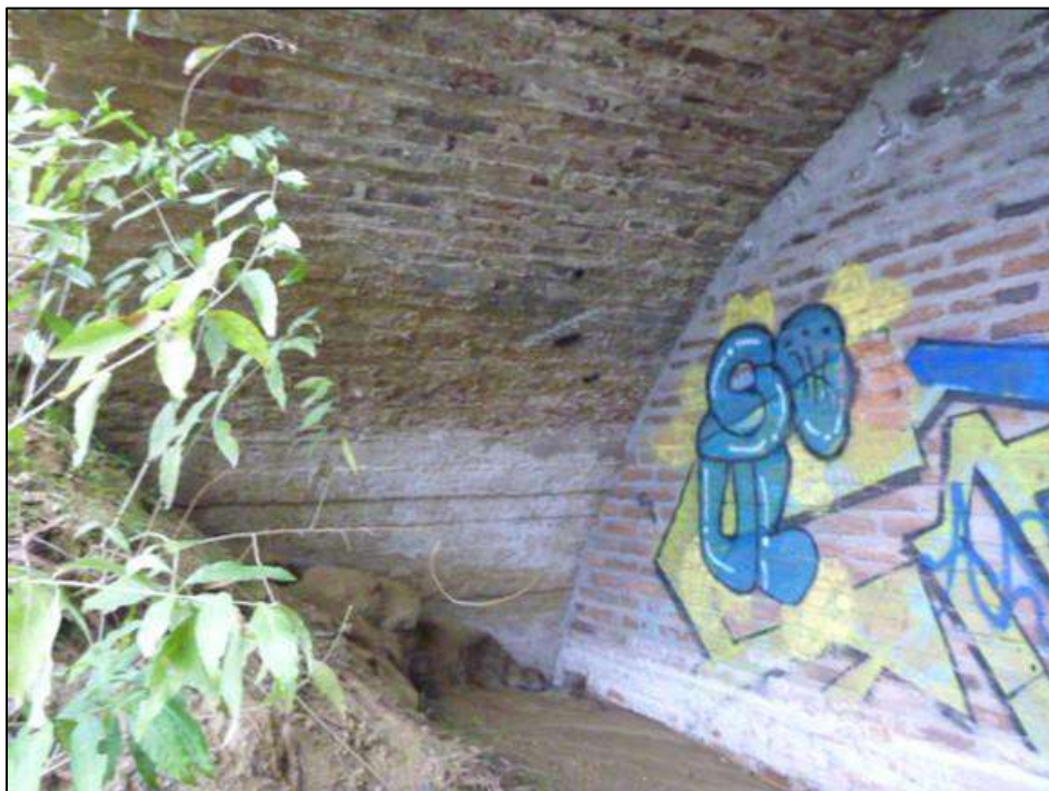
Fotografía 3-48. Interior del túnel.
