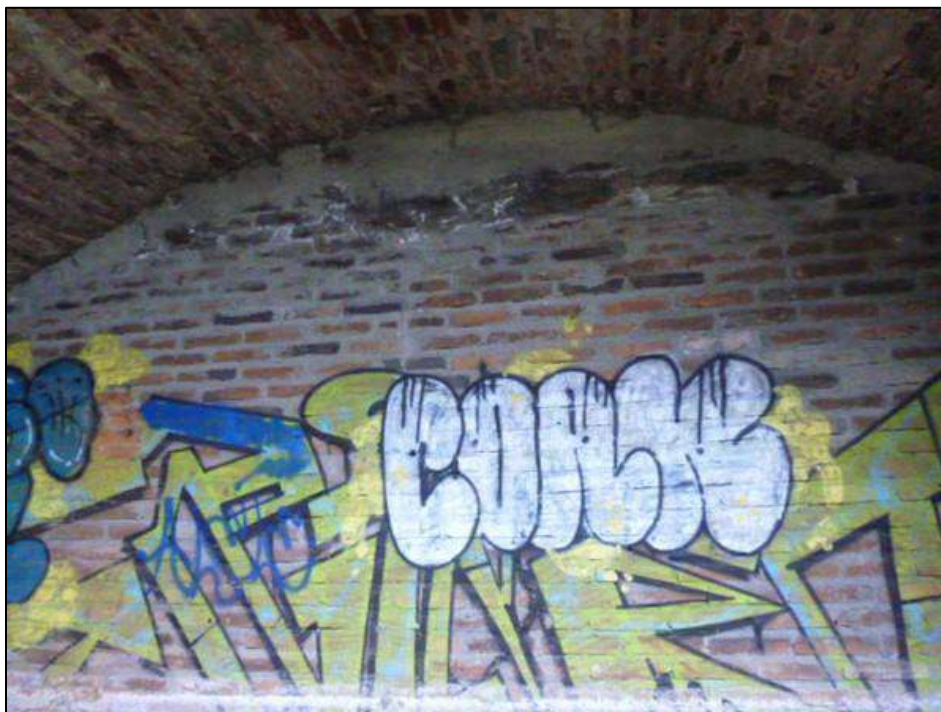
Fotografía 3-50. Muro subactual que cerró el acceso al túnel, con grafitis.
